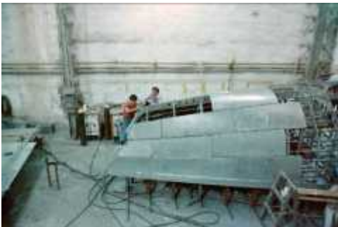
Construction du navire Licor 43. Chantiers navals Bazán, à Carthagène. Photo : MMB.
