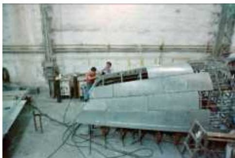
Construcció del buc del Licor 43. Drassanes de Bazán, a Cartagena. Foto: MMB.
